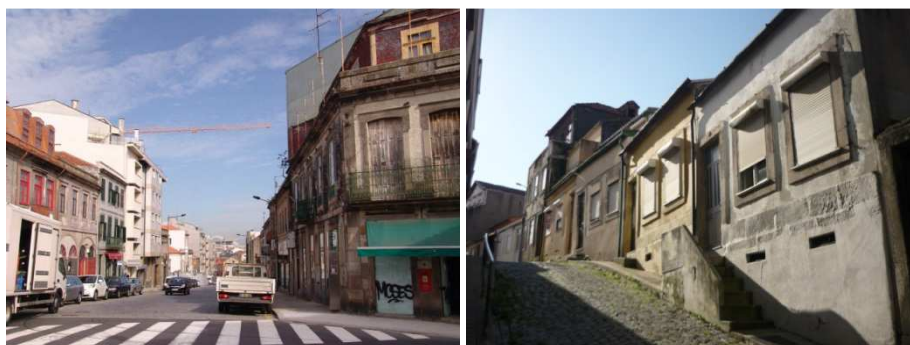
Fig. 10 Rua do Padre António Vieira e rua de São Lourenço
