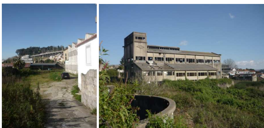
Fig. 16 Terrenos da frente de rio com indústrias desativadas
