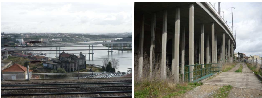
Fig. 18 Estruturas da ferrovia
