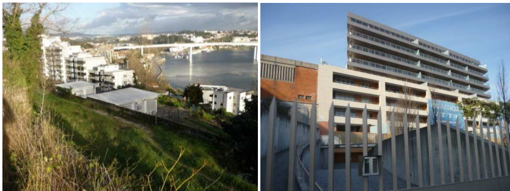
Fig. 17 Edifícios residenciais “Varandas do Douro” e “Ancoradouro”
