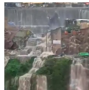
Cascatas devido a chuvas extremas nas escarpas
