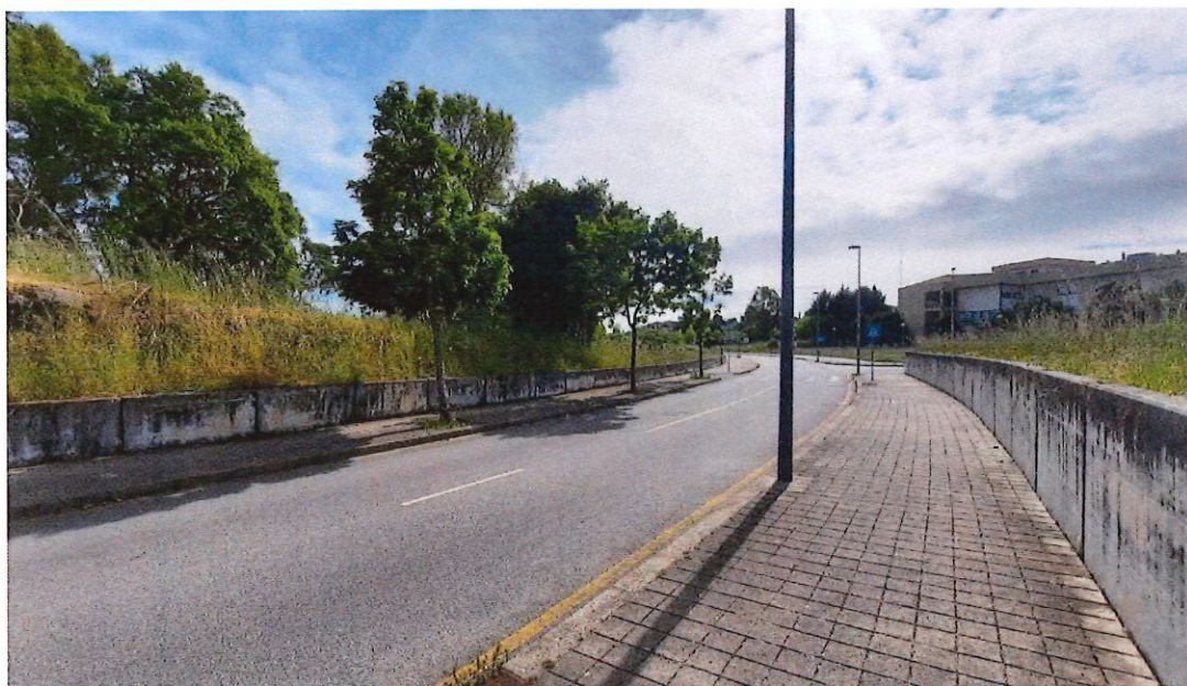
Figura 10 - Frente de rua do Prédio C
