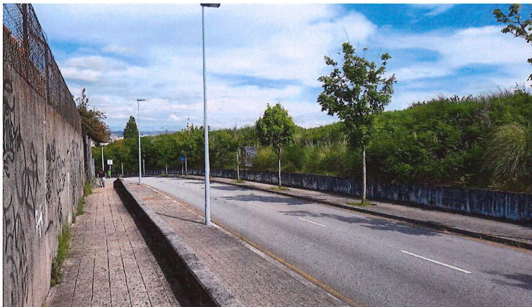
Figura 8 -Frente de rua do Prédio A
