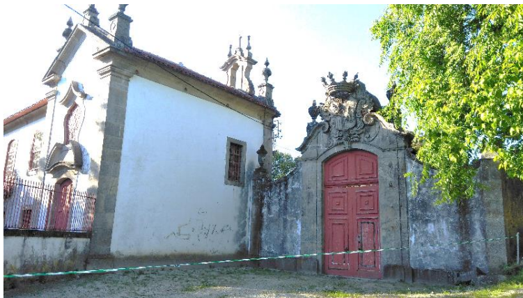
Figura 11. Casa e capela da Quinta da Revolta
