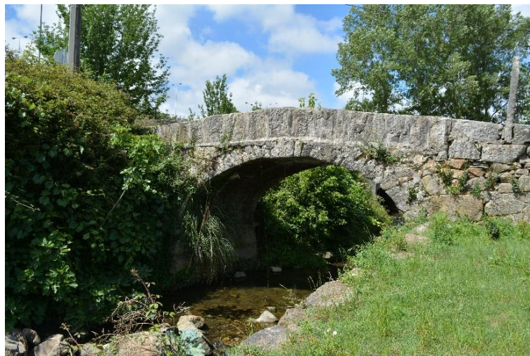
Figura 42. Ponte de Tirares
