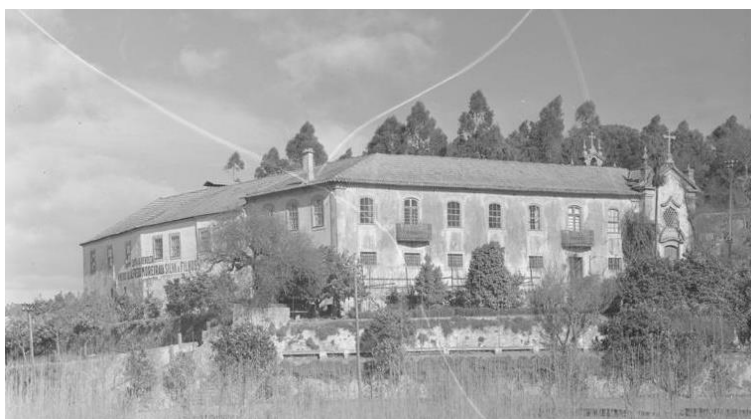
Figura 23. Casa e capela da Quinta da Revolta
